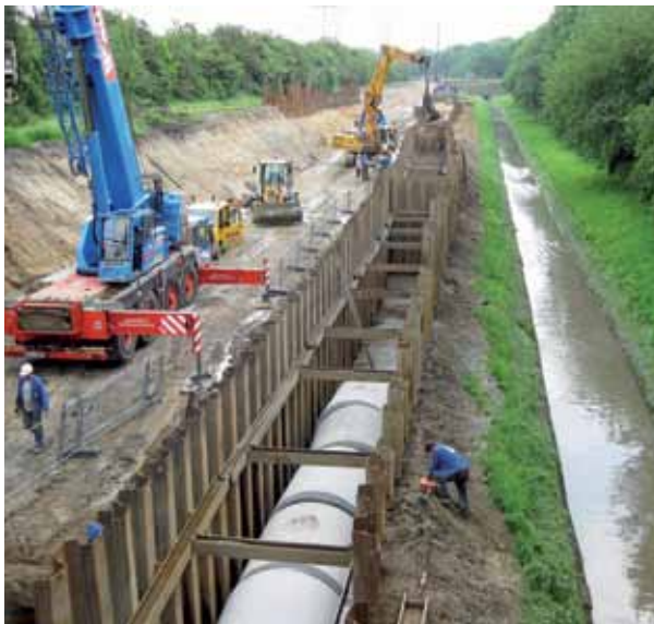
Neue Rohre für das Schmutzwasser
