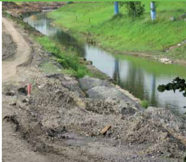
Emscher-Umbau: Nebenlauf Körnebach
